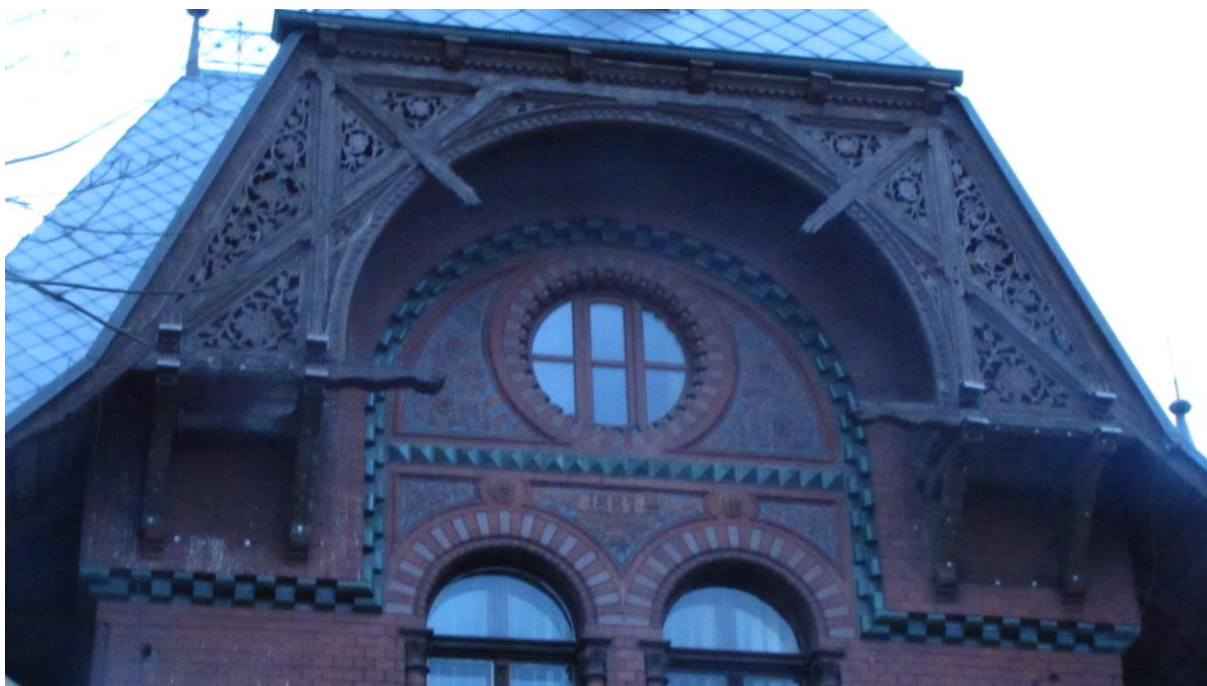
Fot 1. Elewacja frontowa z pięknymi ozdobnikami drewnianymi. Mateusz Stankiewicz 2024
