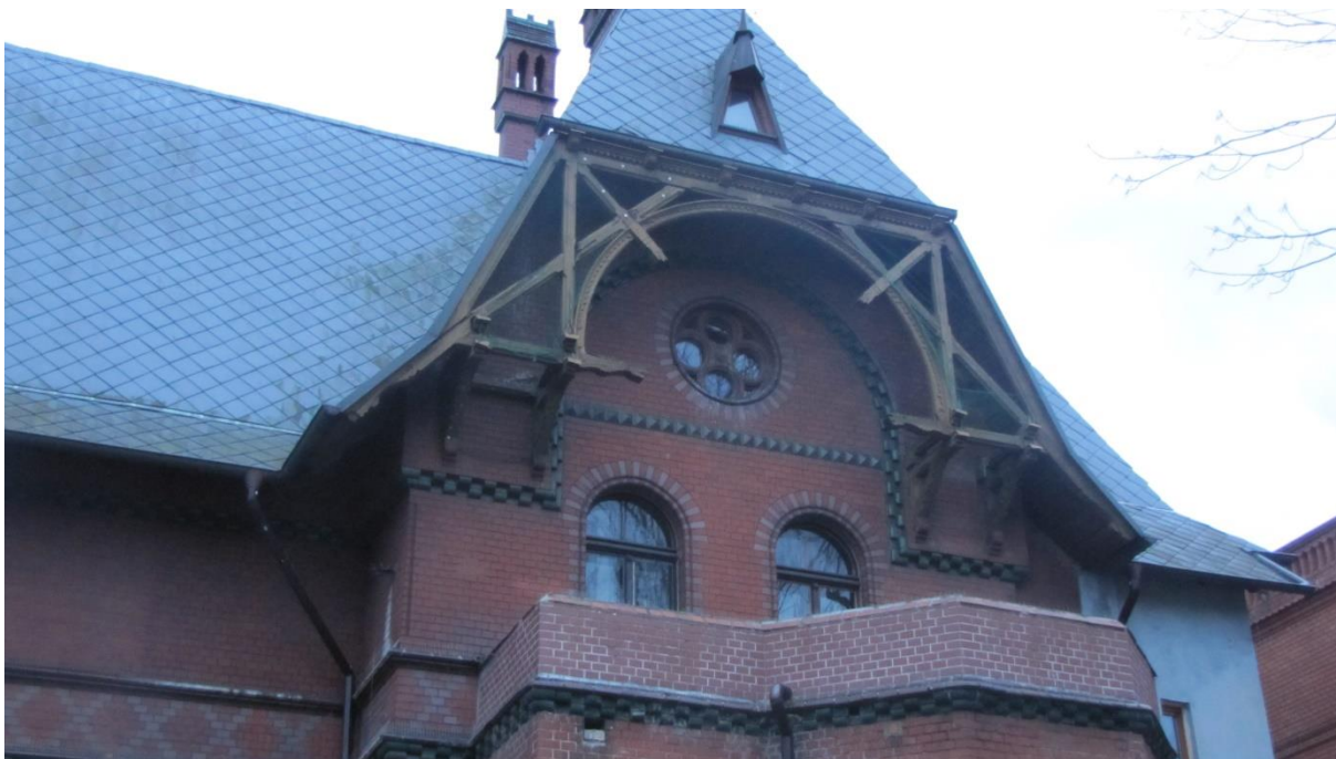
Fot 7 . Widok na drewnianą konstrukcję elewacji budynku NOT. Mateusz Stankiewicz 2024
