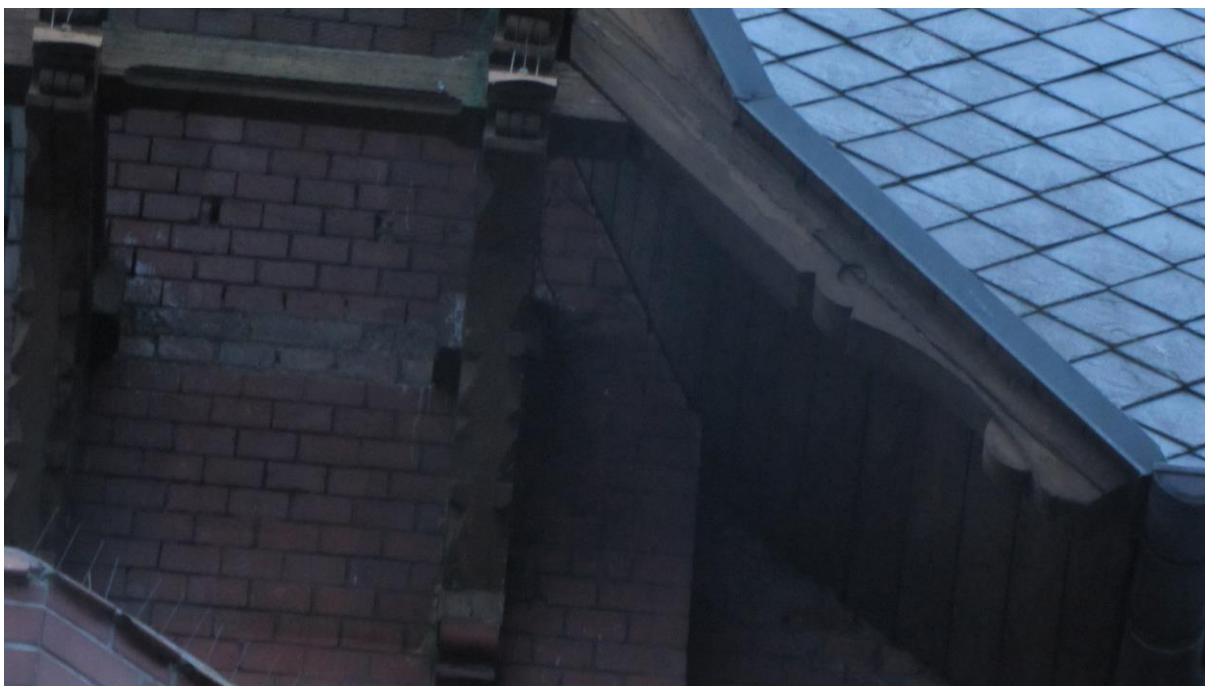
Fot 6. Widok na drewnianą podbitkę dachu budynku NOT. Mateusz Stankiewicz 2024.
